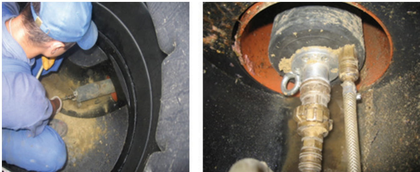
Fot. 3. Montaż korka ze studzienki w badanym kanale.
