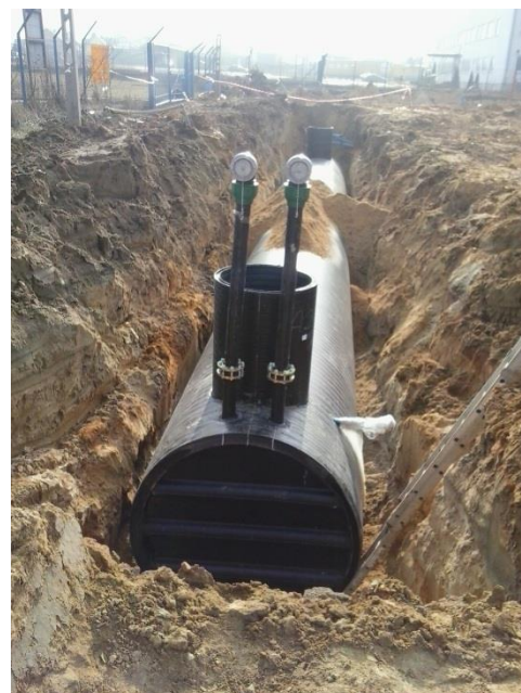
Rys. 10 Zbiornik ppoż. z rury strukturalnej
