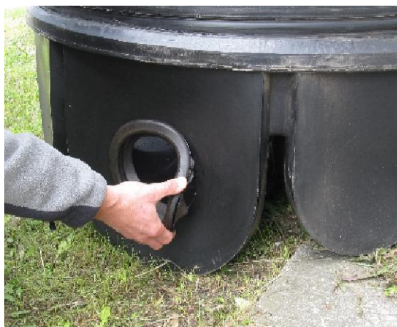
Zdj. 3 Montaż uszczelki wlotowej
