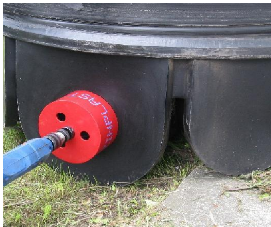
Zdj. 1 Wiercenie otworu wyrzynarką
