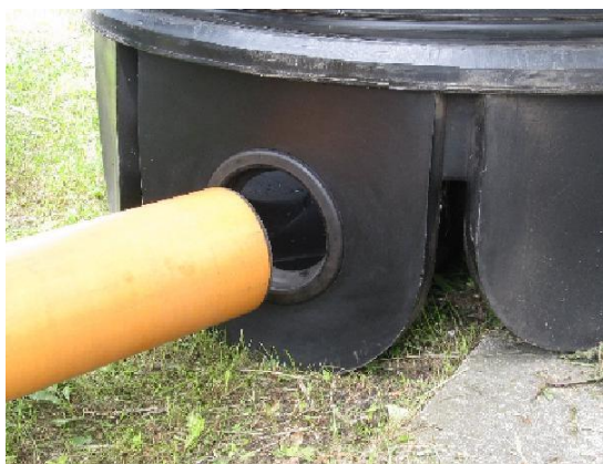
Zdj. 4 Montaż rury wlotowej
